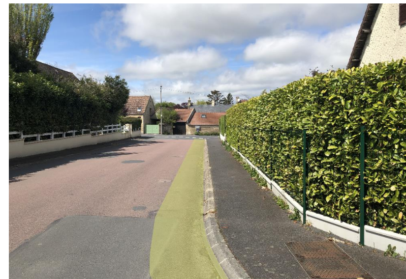
Élargissement du trottoir (environ 110 cm)
