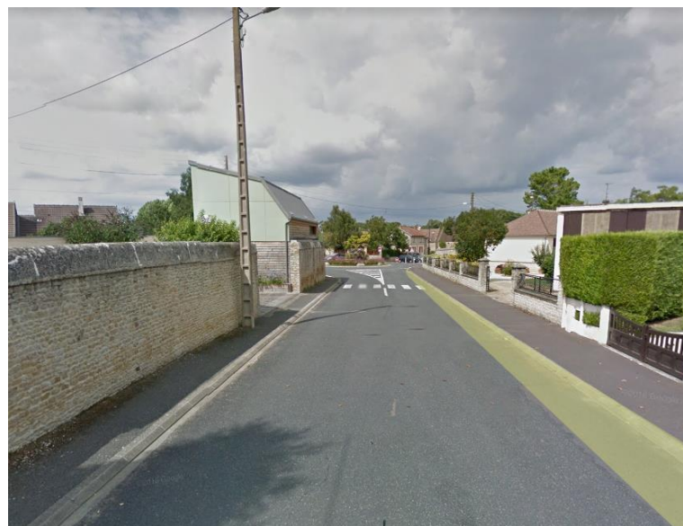
Élargissement du trottoir (environ 70 cm)
